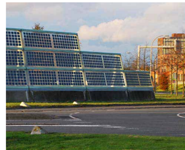
Mur anti-bruit en technologie photovoltaïque
