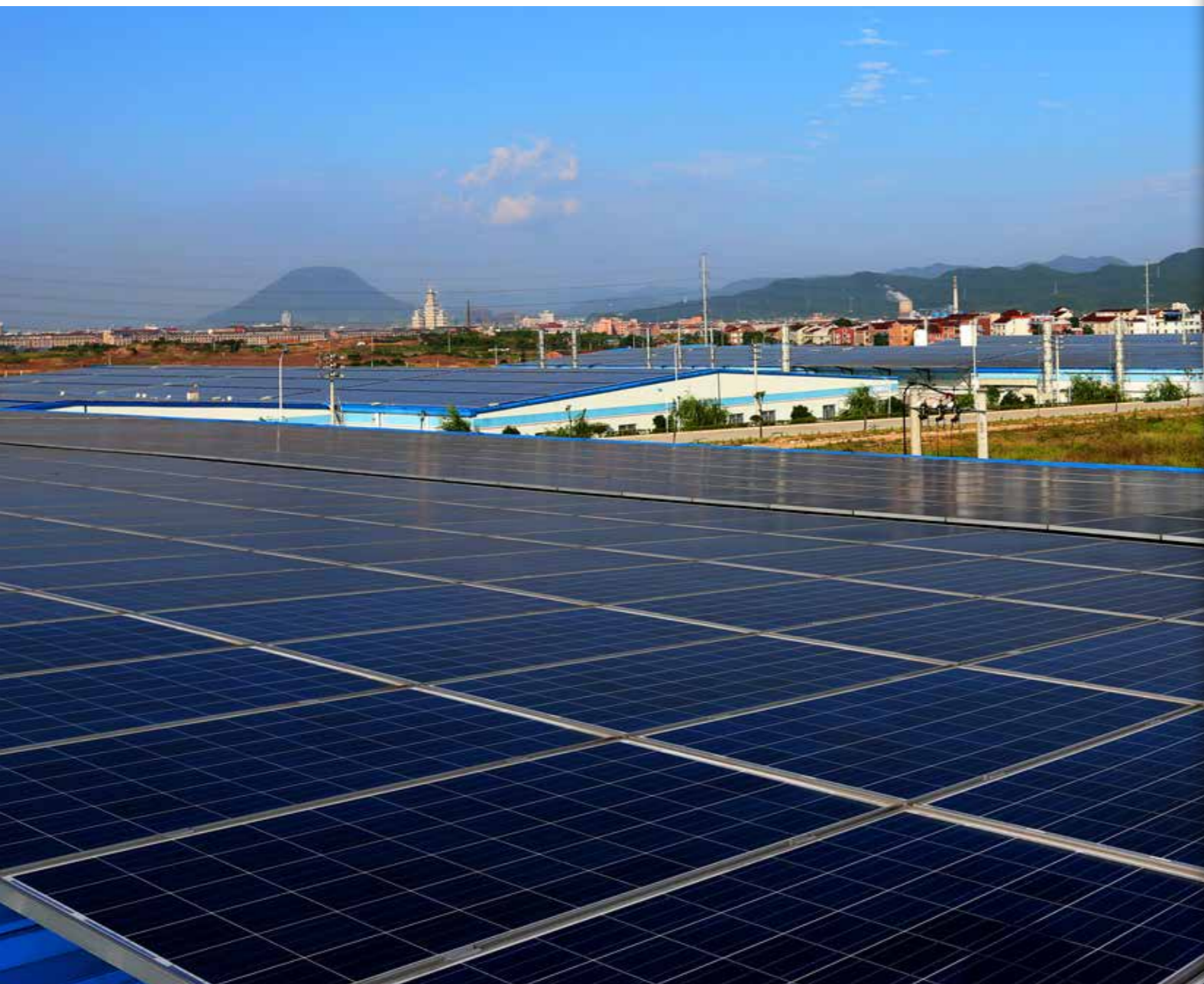
Modules solaires sur les toits de l'usine DMEGC
